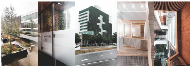
Abbildung 2: zeigt das Stadthaus in Venlo, Niederlande. Beschreibung von links nach rechts: Außenanlage zur Reinigung des Wassers – Innenräume mit begrünten Wänden für ein gesundes Raumklima – begrünte Nordfassade – Treppen Kern als Kommunikationsbereich aus Holz - Innenkonstruktion der Fassade Aluminium und HOLElementen.
