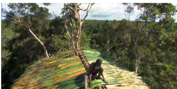
Abb. 4: Das Dach eines Baumhauses wird von einem Korowai mit Blättern der Sagopalme gedeckt
