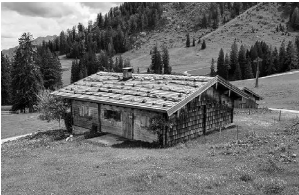
Abb 2: Hütte in der österreichischen Alm mit Beschwerung der Dachkonstruktion durch Steine
