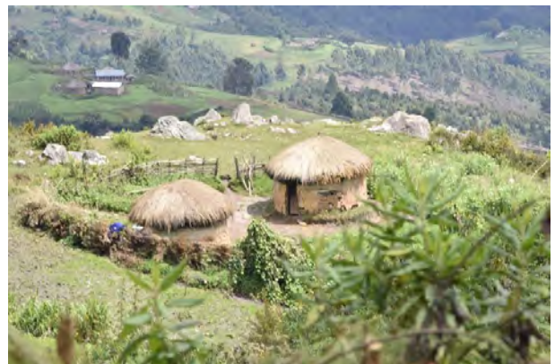
Abb. 2: Bienenkorbhaus mit Lehmwänden
