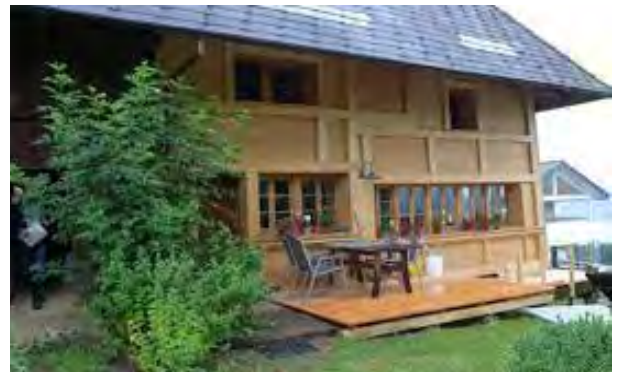
Abb. 6: Sanierung Hochstudhaus, Untere Wanne 10, Birrwil
