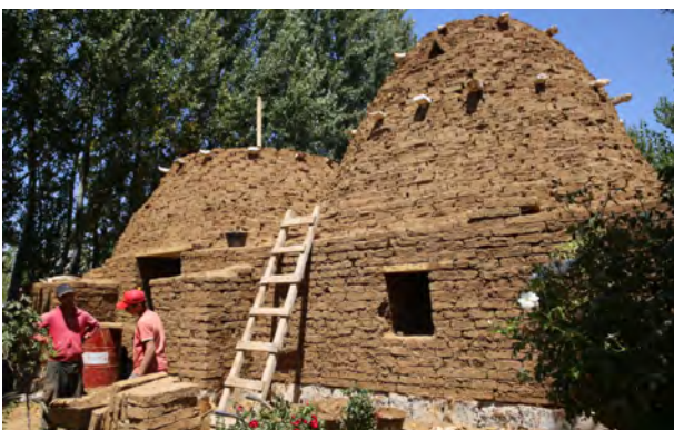
Abb 1: Traditionelle Fertigung eines Lehmkuppelhauses in Aleppo, 2010
