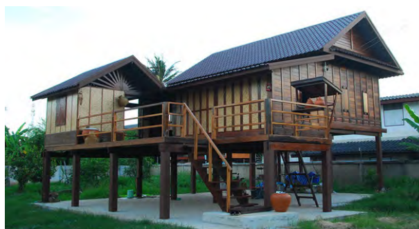
Abb 2: Das Beispielobjekt, das im Stil des „Huen Korat“ nachgebaut wurde
