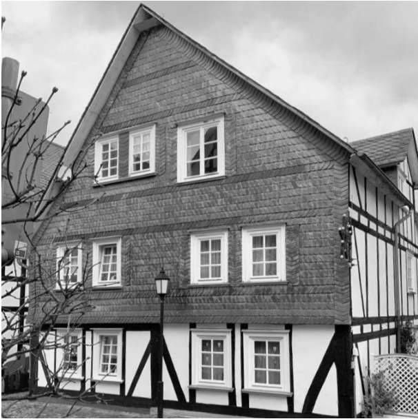
Abb. 4: Verschieftes Fachwerkhaus in Freudenberg (Quelle: eigen)
