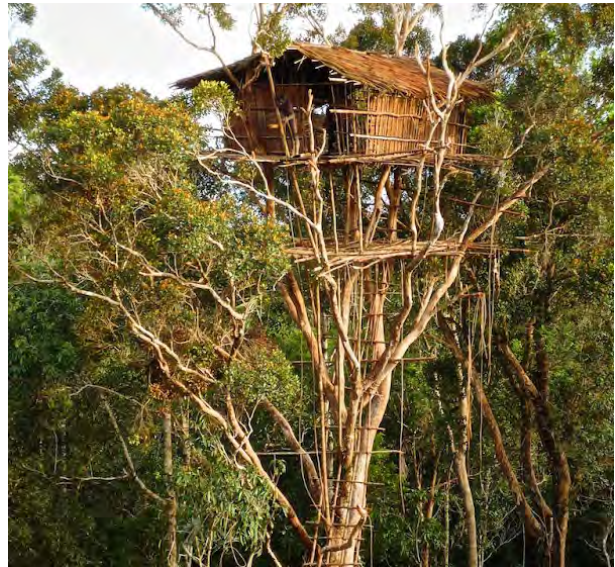
Abb. 3: Das Baumhaus wird hauptsächlich von zentralem Baumstamm getragen
