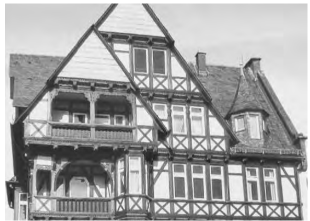
Abb. 5: Fachwerkhaus mit rechteckigen, dreieckigen und kreisförmigen Geometrien (Quelle: Gerner, 2007)
