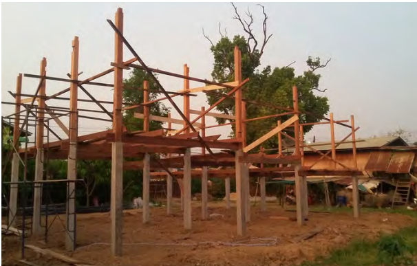
Abb 3: Die Primärkonstruktion mit Stelzen und Holzgerüst
