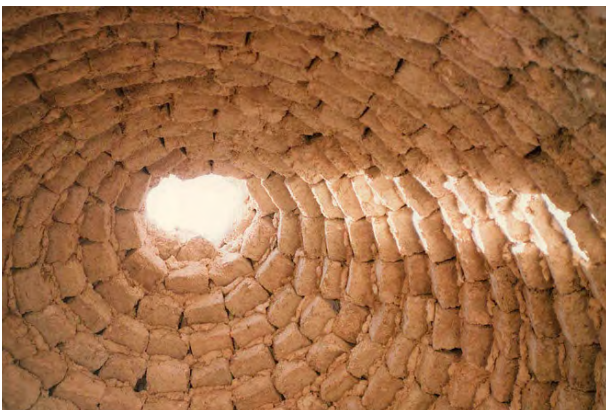
Abb 5: Kuppelaufbau, Materialdarstellung, Syrien
